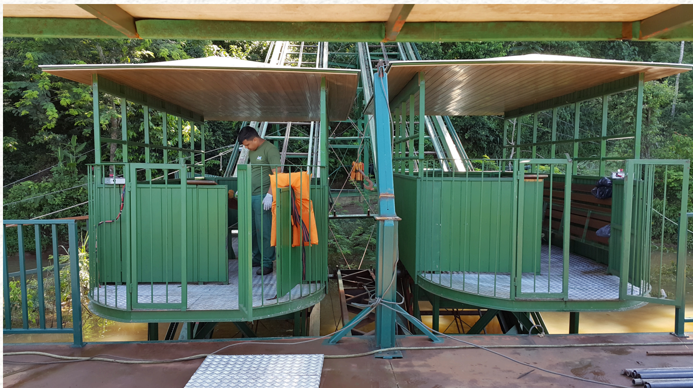
Manutenção em Plano Inclinado.
